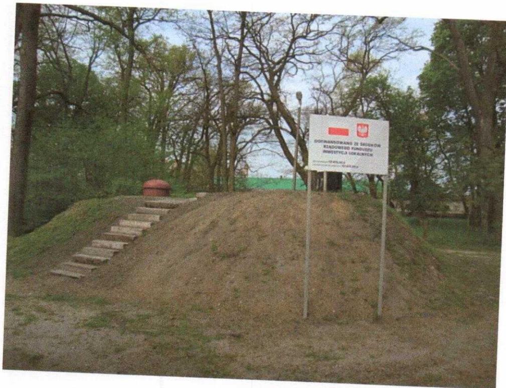
Zbiornik 50000 l na Stacji Uzdatniania Wody - Borowe
