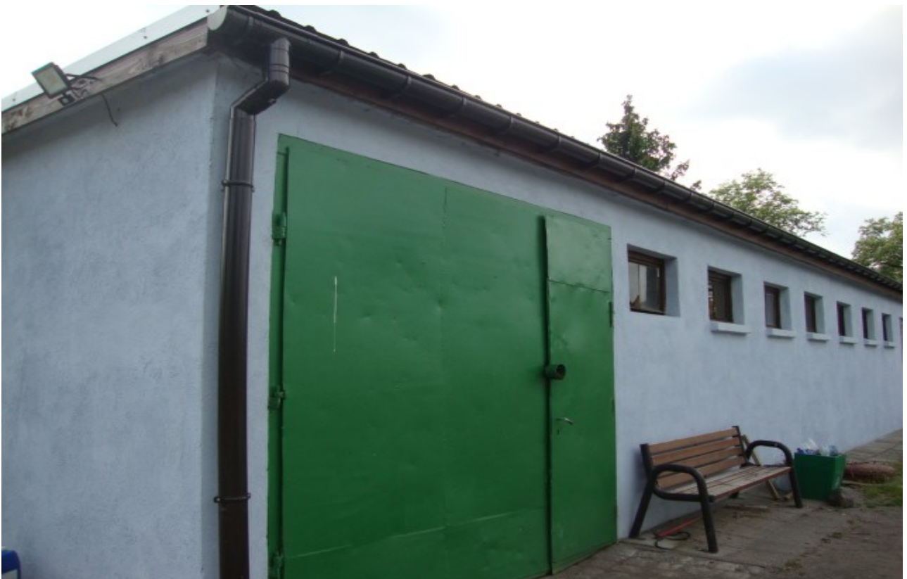
REMONT BUDYNKU ( budynek po byłym zakładzie gospodarki komunalnej)
